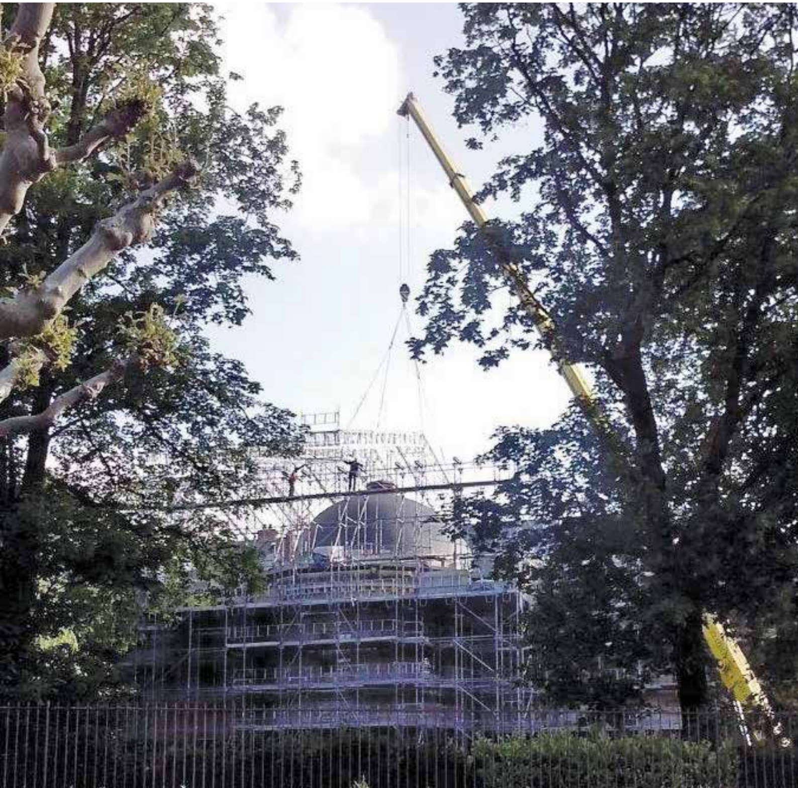
Opération de retrait du «parapluie» de l'hôtel préfectoral de Besançon
