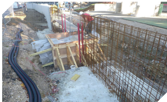
Protection du vestige - septembre 2015
