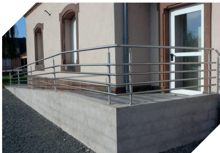
Rampe d'accès aux personnes à mobilité réduite
