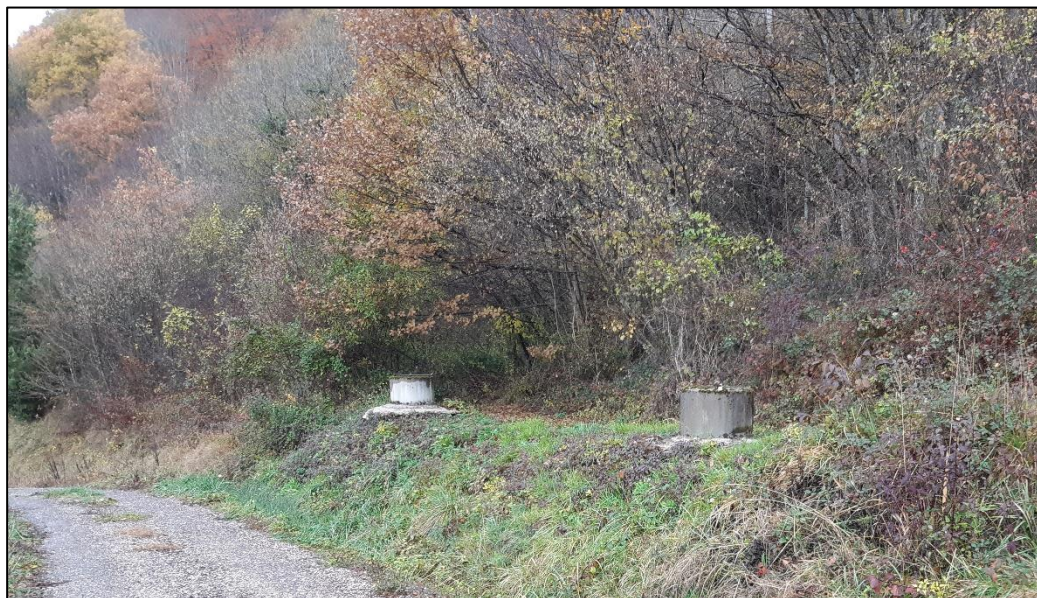
Figure 9 : Vue extérieure du captage
