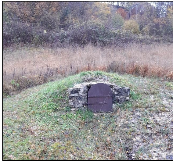
Figure 4 : Vue sur la chambre de collecte
