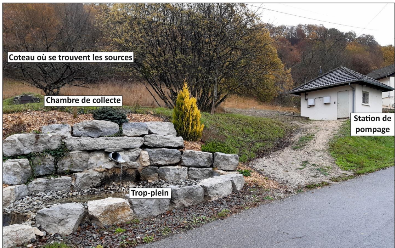
Figure 5 : Vue sur la station de pompage et la fontaine aménagée
