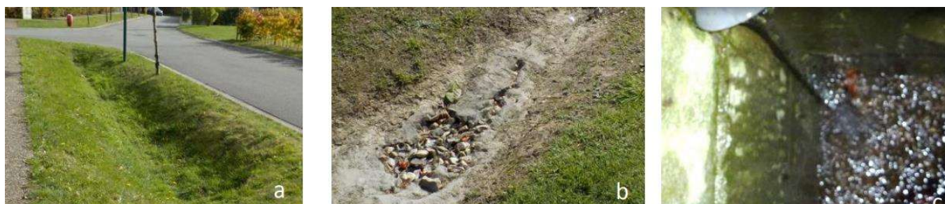
Figure 38 : a) Noue drainante - b) Massif drainant sous géotextile - c) rejet des eaux issues des massifs drainants dans un regard en aval - AREAS
