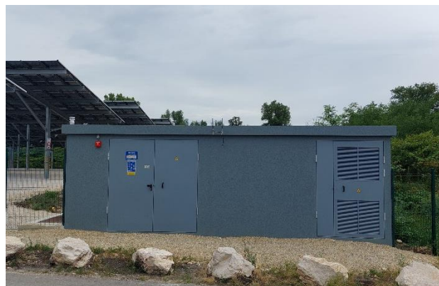
Figure 6 : Exemple d'installation d'un poste de livraison
