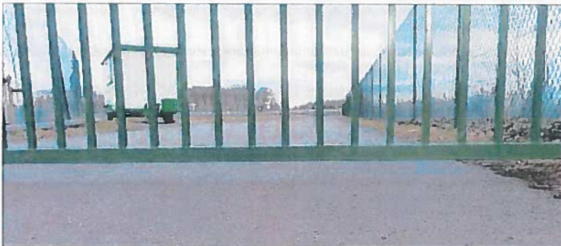
Exemple de bassin de décantation mal protégé au niveau de l'entrée (photo Thauront/Ecosphère)
